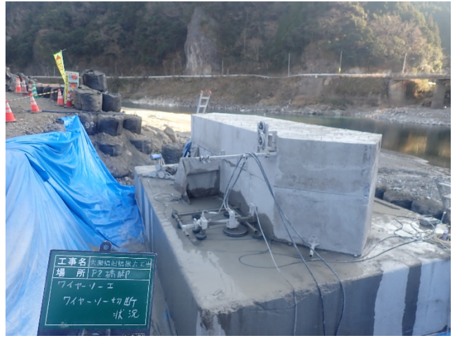
橋脚撤去状況（フーチングまで分割切断撤去）
