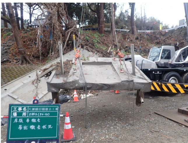
1・3径間目 ポステンT桁撤去状況
