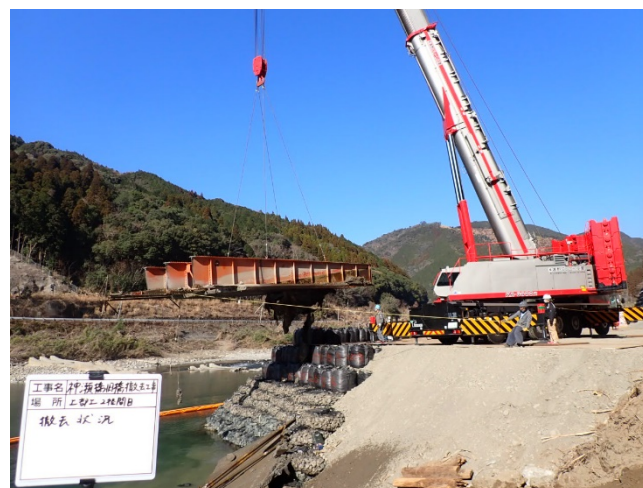
2径間目 鋼鈹桁撤去状況
