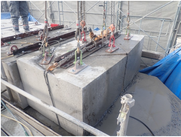
橋脚撤去状況（フーチングまで分割切断撤去）
