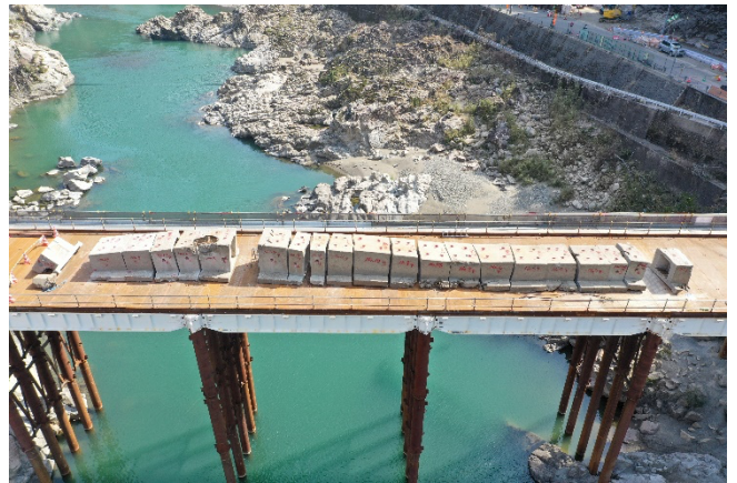
1-3 径間 水没上部工分割撤去状況
