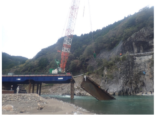
2 径間目 ワーレントラス橋撤去状況（陸上・水没部）
