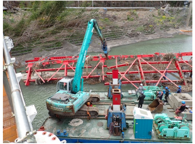
2 径間目ワーレントラス撤去状況
