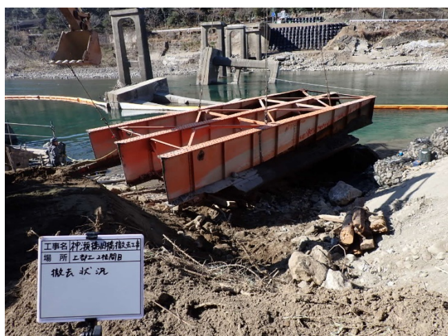
2径間目 鋼鈹桁撤去状況
