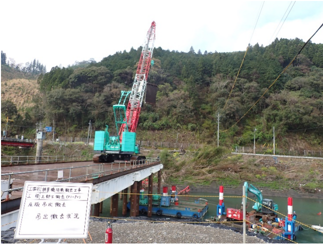
2 径間目ワーレントラス撤去状況
