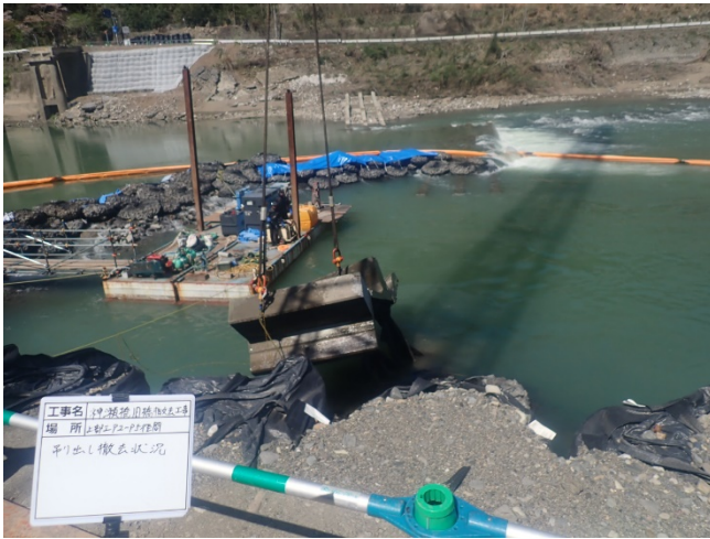
3 - 5 径間目 RC 3 径間連 T 部分撤去状況
