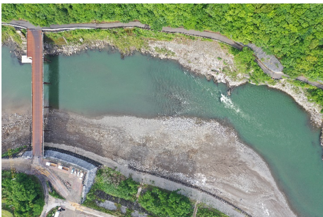
撤去完了（旧橋位置へ作業構台設置・残置）
