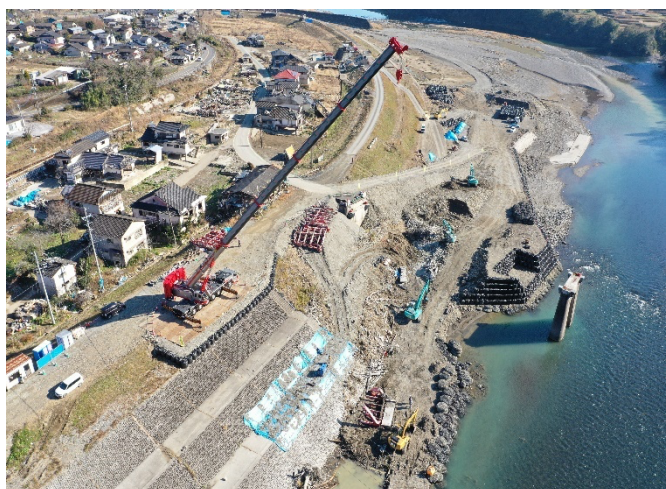
3径間目ワーレントラス撤去状況
