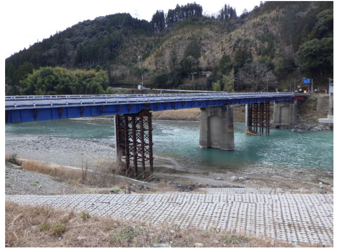
撤去完了 (旧橋下部工を利用した車両用仮設栈橋設置)
