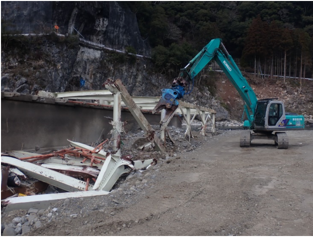
2 径間目 ワーレントラス橋撤去状況（陸上・水没部）
