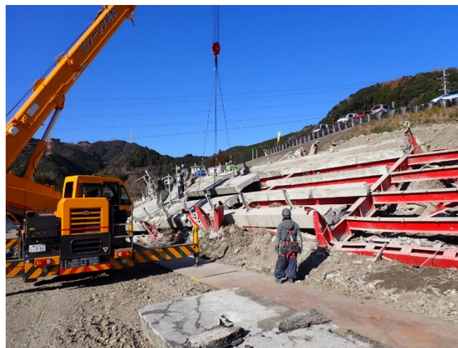
3径間目ワーレントラス撤去状況
